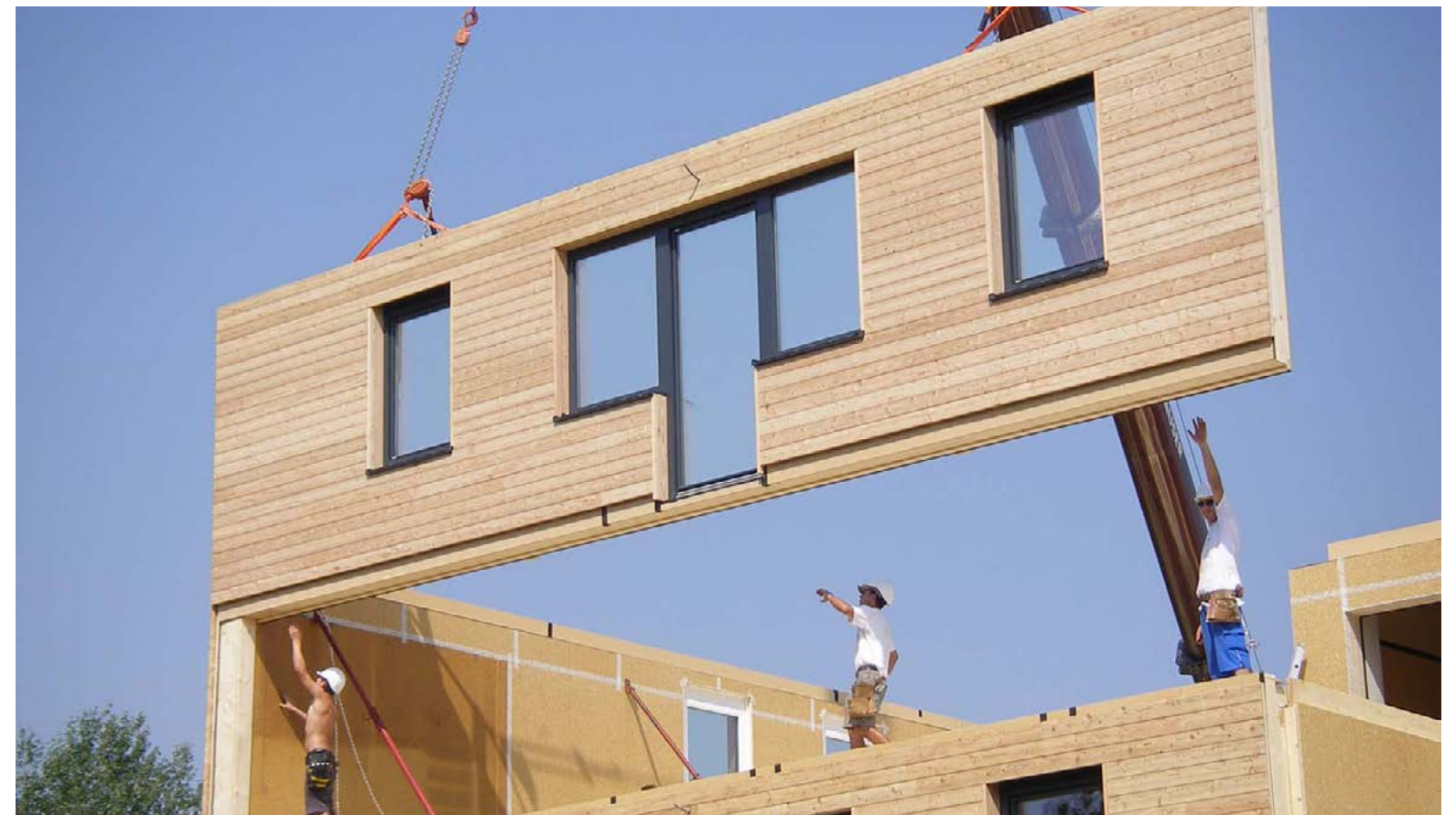
Vorgefertigte Holzbauteile ermöglichen hohe Präzision und kurze Bauzeiten
