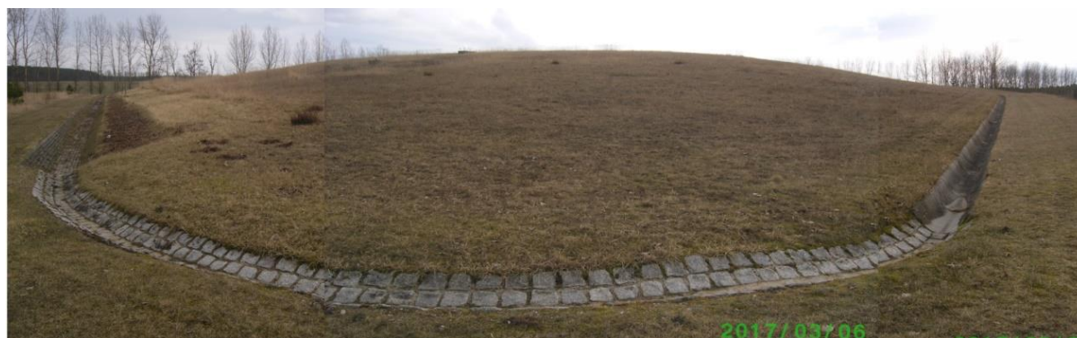
Foto 5: Panoramaansicht der stillgelegten Deponie Selchow
